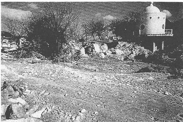
図-6 地震後のニテコ池、上堤の様子
