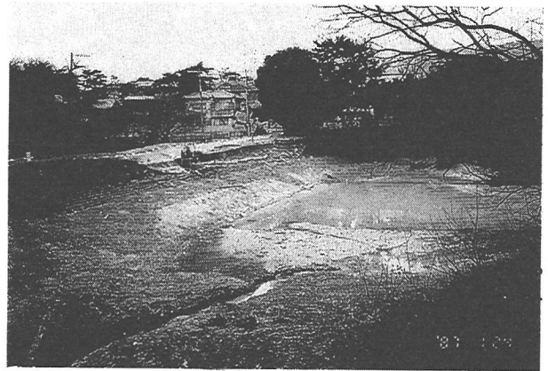
図-8 地震後のニテコ池、下堤の様子 (石原教授による)
