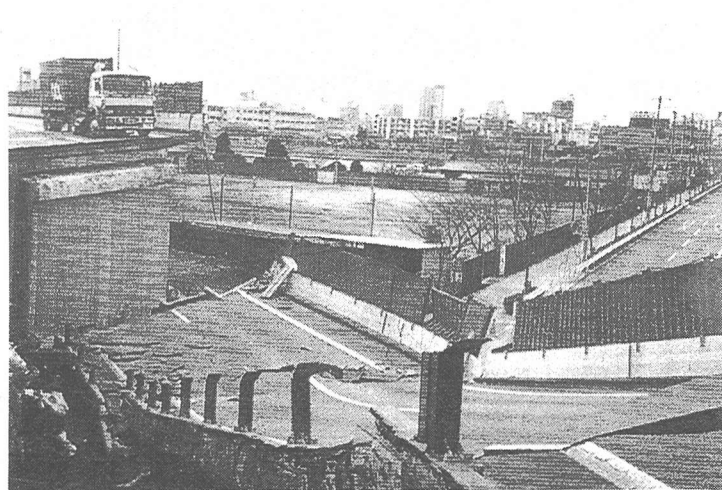
写真-2 瓦木西高架橋の落橋
