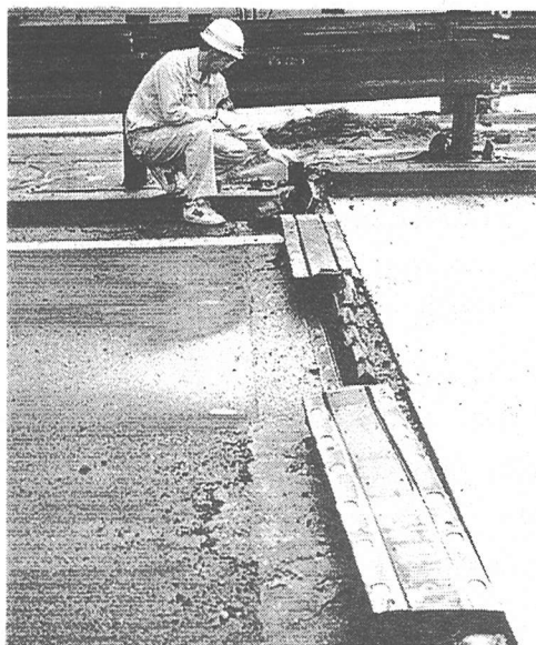
写真-11 ジョイントの損傷 (宝塚VA)
