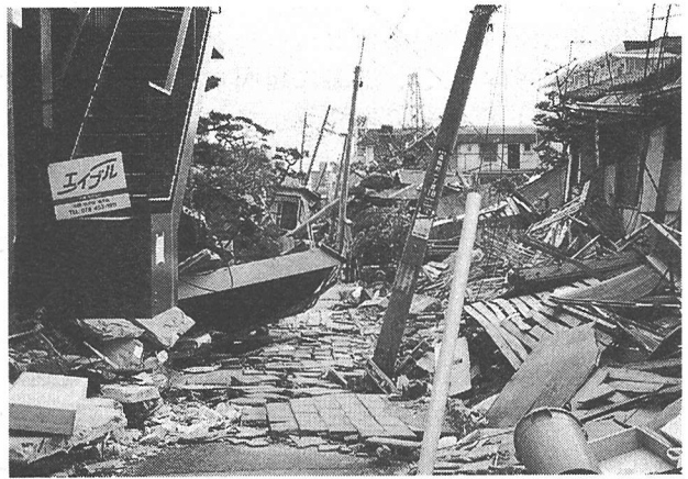
写真-2 倒壊した家屋により閉塞された地区道路 (森南町、2月撮影)
