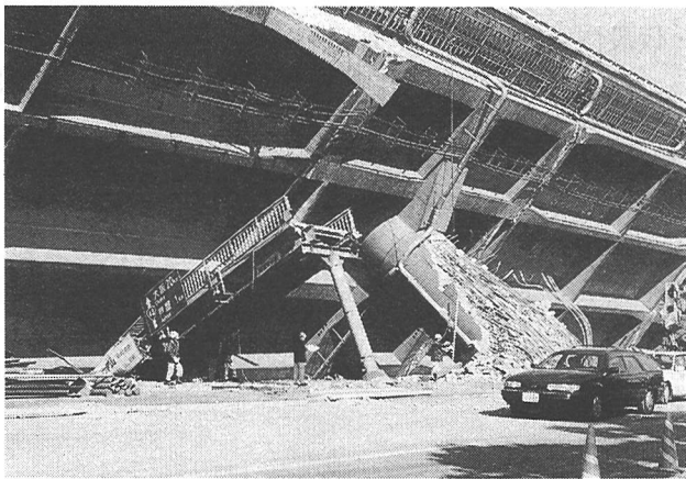
写真-1 倒壊した阪神高速道路神戸線 (深江本町、1月19日撮影)
