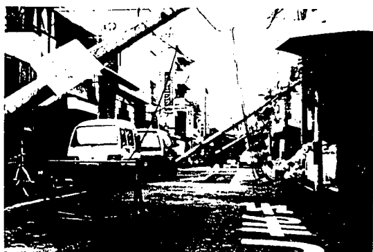
写真-1 電柱の倒壊による街路閉塞の一例
