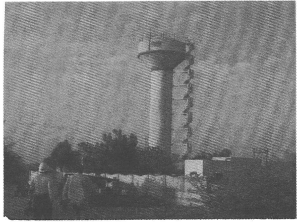
写真-19 Maliya の給水塔
