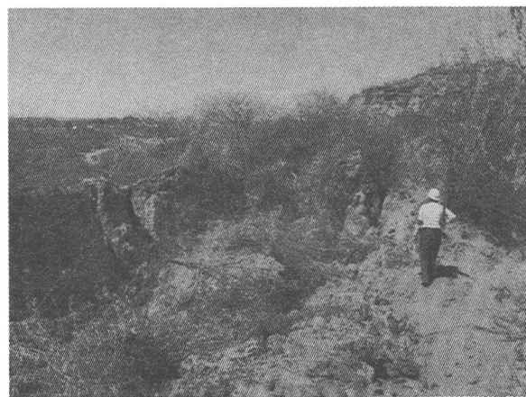
写真-10 堤頂部の大被害
