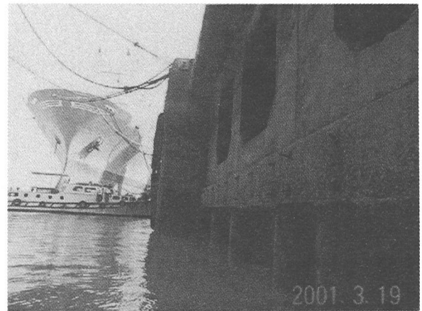
写真-6 Kandla 埠頭のパイロン
