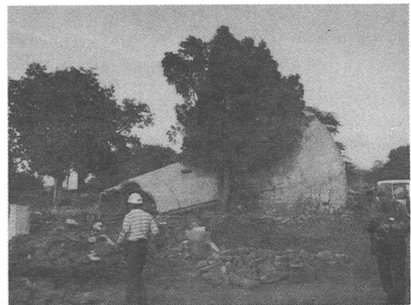
写真-21 Chobari の倒壊した給水塔
