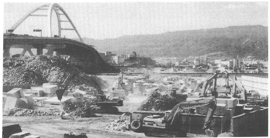
写真-11 破碎作業状況（甲子園浜）
