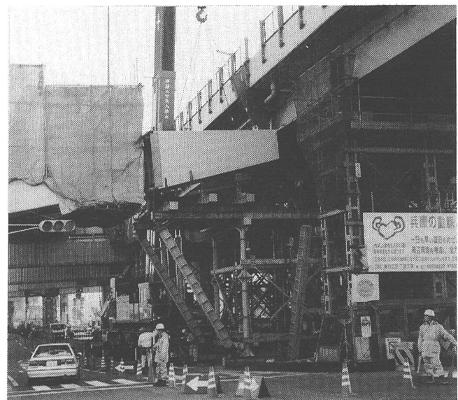
写真-10 ヒンジ式ベントでの架設状況
