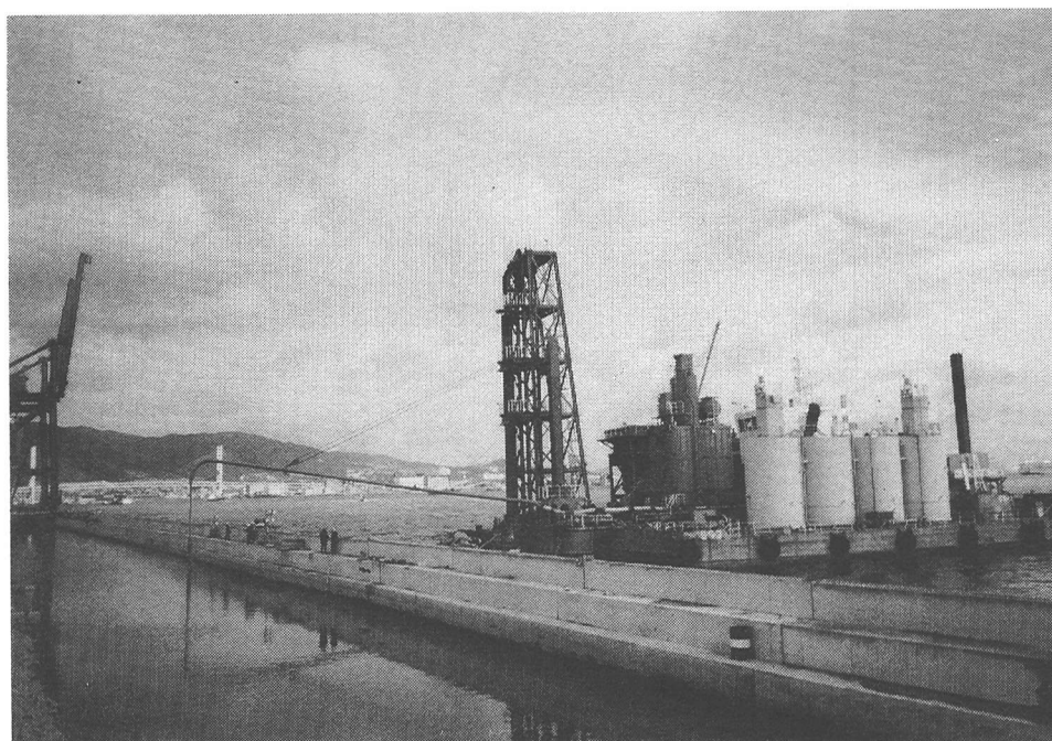
(写真-3) 軽量混合土施工状況
