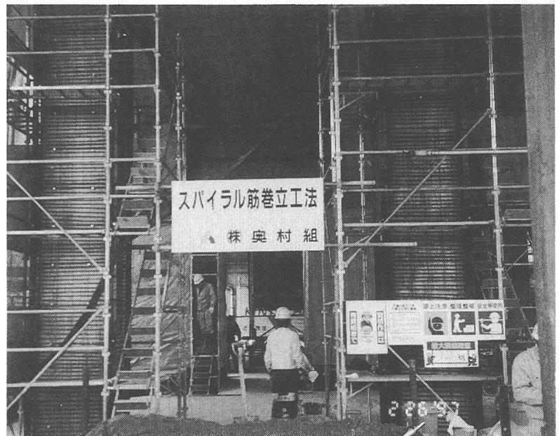
写真-6.1 スパイラル筋巻立法実施状況
