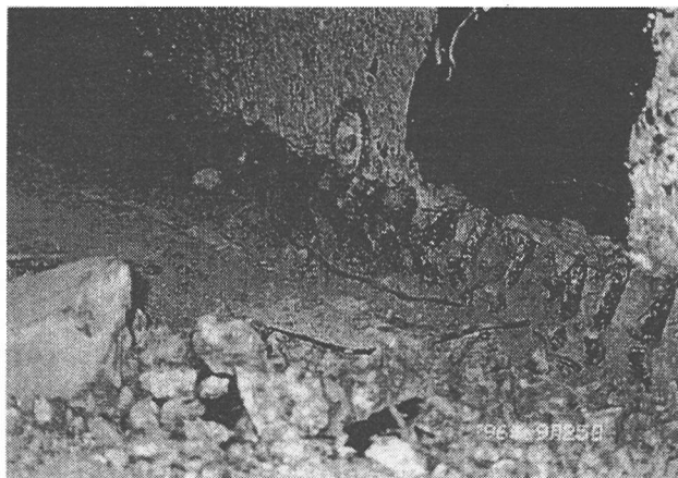
写真-3 No. 5試験体の損傷状況
