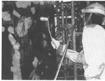
2. プライマー塗布工
