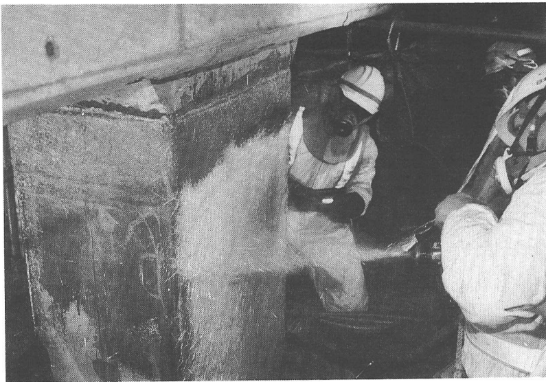
写真-1 GFRP吹付け施工状況
