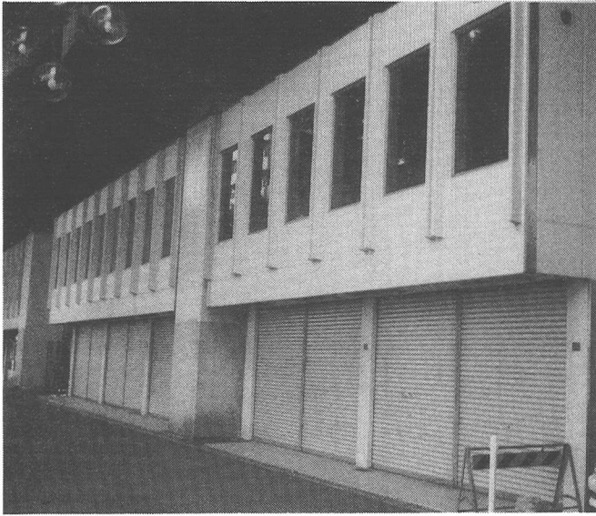
写真-1 現場状況
