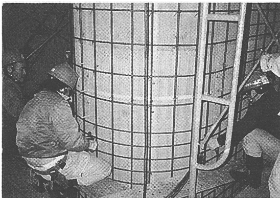
写真-2 鉄筋設置状況
