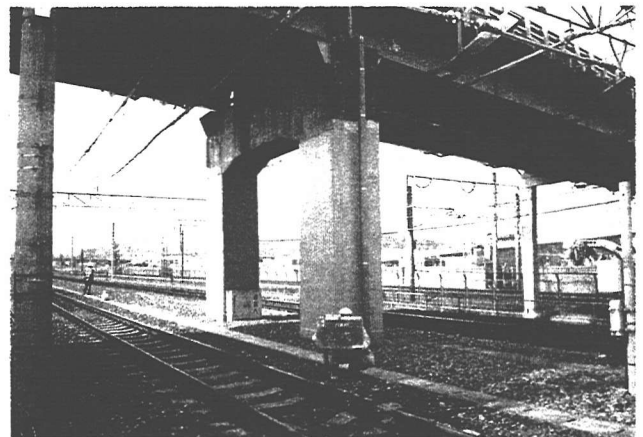
写真-5 完成状況
