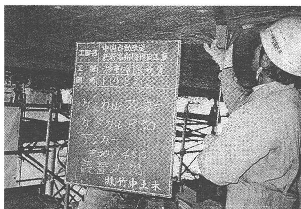
写真-18 ケミカルアンカー設置状況
