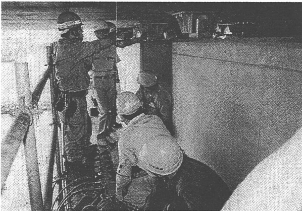
写真-12 油圧系統の整備
