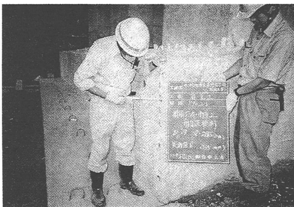
写真-6 樹脂アンカー削孔長の確認
