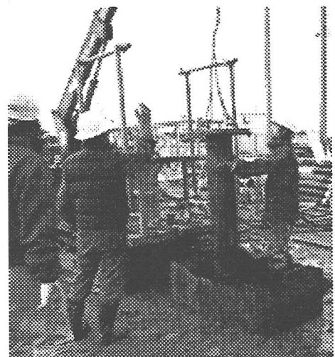
写真-3 集水ピット ガイド管
