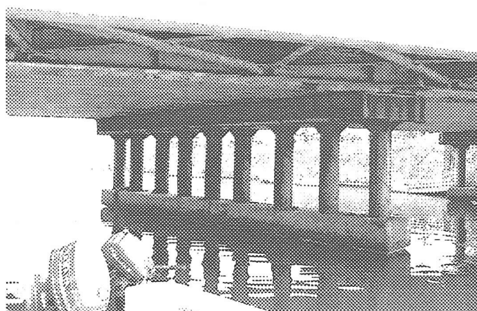
写真-1 橋脚全景写真
