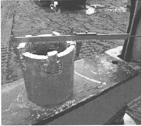
写真-4 削孔ビット
