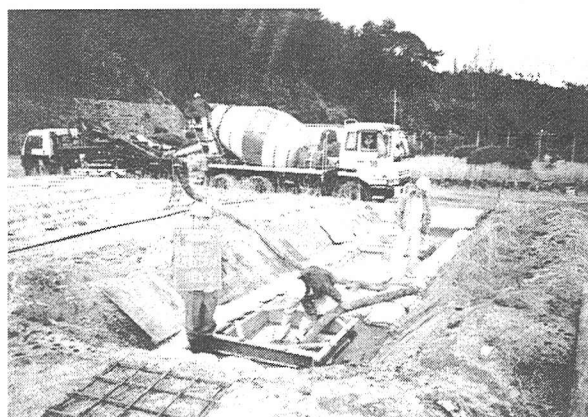
写真-3 打設状況
