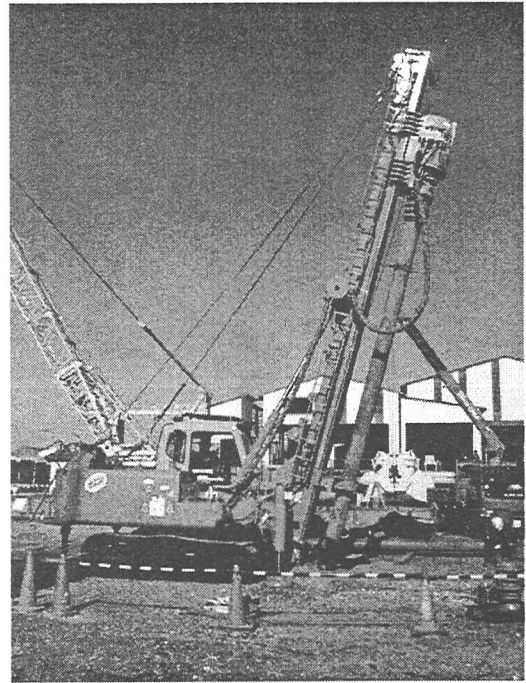
写真-2 斜杭施工状況（施工機方向）
