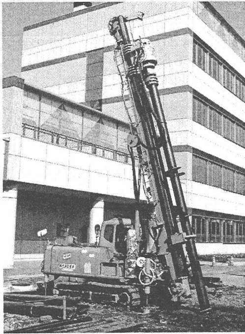
写真-1 斜杭施工状況（施工機前方）
