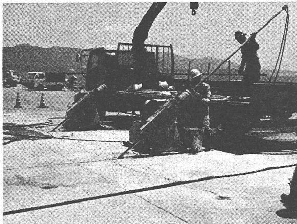
写真-1 予備注入状況
