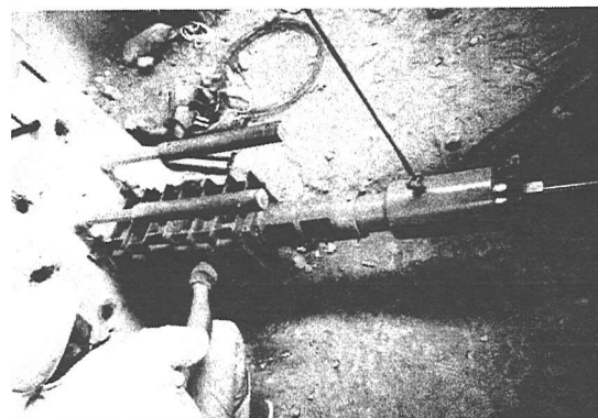
写真-7 現場引張試験状況
