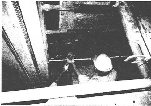
写真-12 アラミドFRP ロッドの緊張
