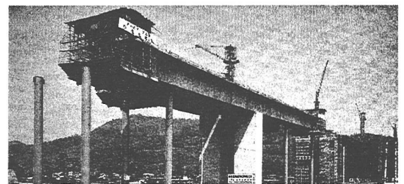
写真-2 施工状況
