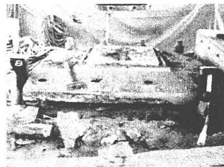
下支承部のはつり
