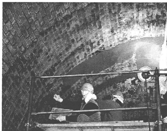
写真 5 煉瓦トンネル適用事例
