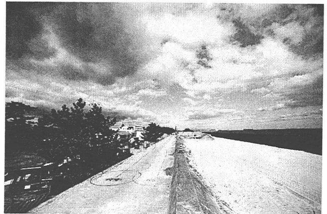
写真-1 既設護岸堤防
