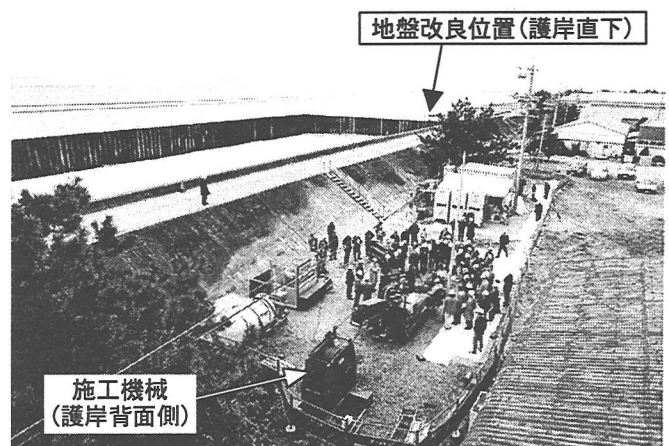
写真-2 施工状況
