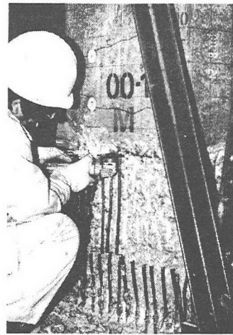
写真-3 軸方向鉄筋(D10)の撤去
