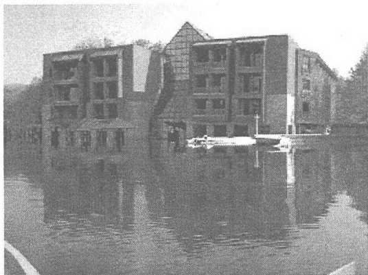
写真-1 サパンチャ・ホテルの浸水状況
