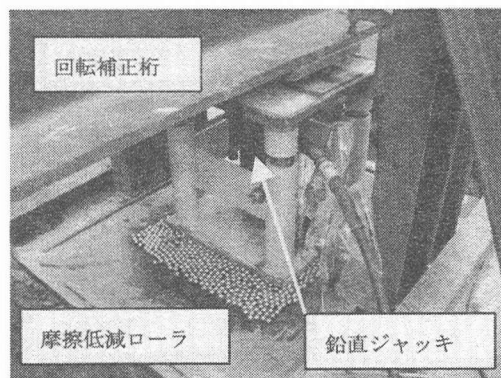
写真-2 鉛直ジャッキ部
