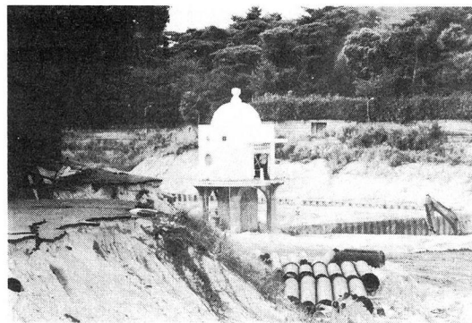
写真2 被災したニテコ池と取水塔
