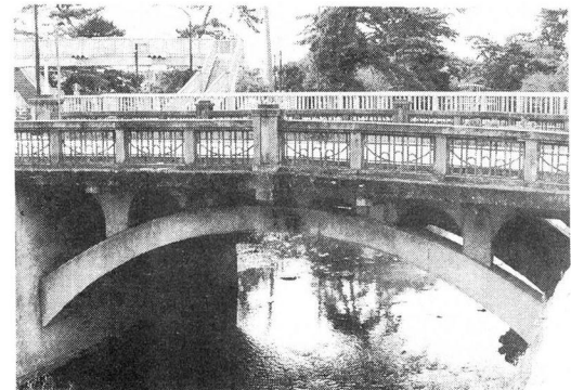
写真3 被災前の羽衣橋
