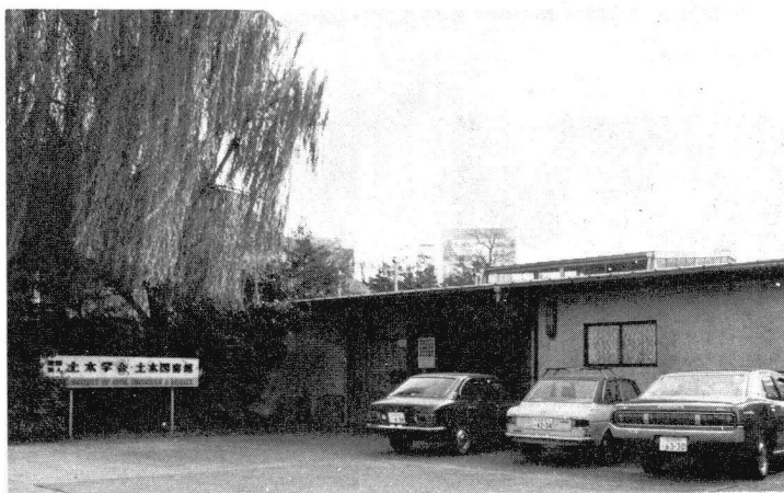
土木学会事務所正面
