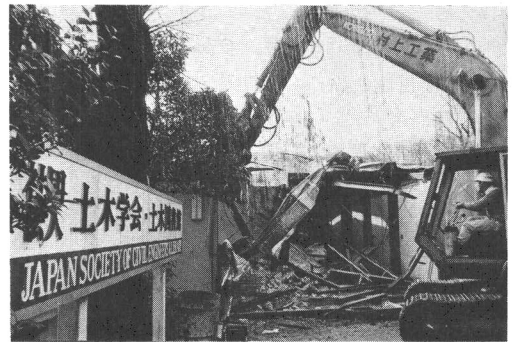
写真 2.10 30年近い使命を終え取りこわし中の旧会館
