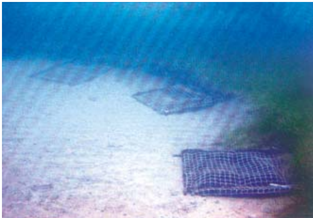
海草移植マットの設置
