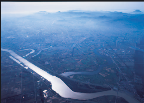
2. 上空から見た石狩川生振捷水路
