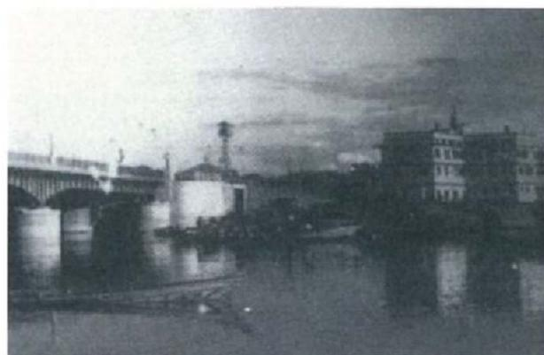
1934年(昭和9年)に3径間・鋼製ゲルバー橋が完成
