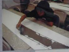
モルタル施工
