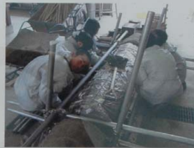
13-の壁厚は 2 cm を基準としてモルタルを打設
