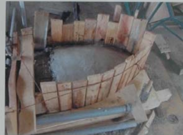
バウ、スターン部分のモルタル打設状況
