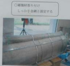
○打設準備 木に水分を吸われないようにすると同時に船の表面を滑らかにします
