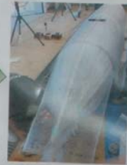
○金網取り 目詰りが生じないように同時にキール部分を取り付け
