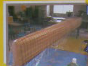
補強鉄筋配置・固定
