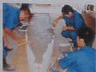
⑦コンクリート打設中
