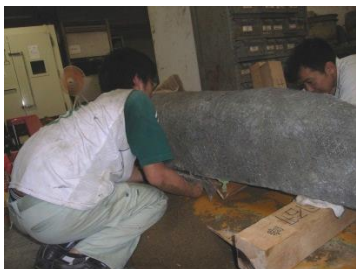
型枠内の土を排出
