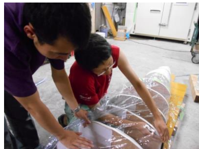
図9 コンパネとシートの固定
