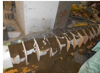
図10 空洞への土の充填
