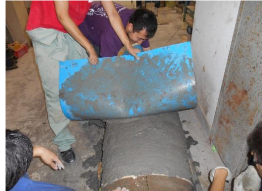
図12 伸ばしたコンクリートを貼り付ける
