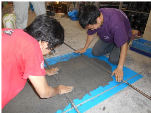
図11 コンクリートを均一な厚さに伸ばす
