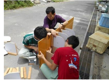
型枠の組み立て
