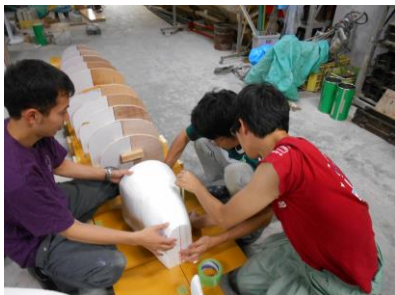
図8 型枠骨組みの組立
