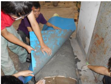
伸ばしたコンクリートの貼り付け
