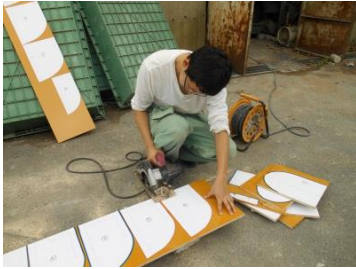
型枠フレームの切り出し
