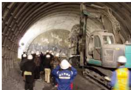
城山八王子トンネル(工事中) ※今年3月に開催した学生向け見学会の様子
