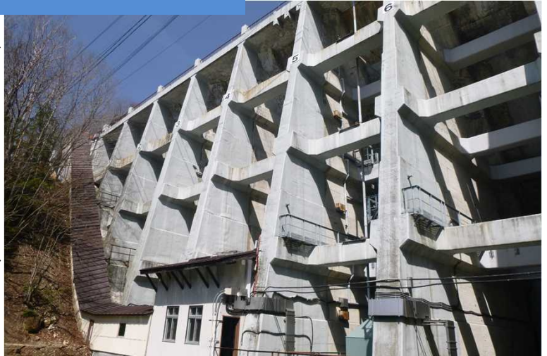
(写真:丸沼ダム)
