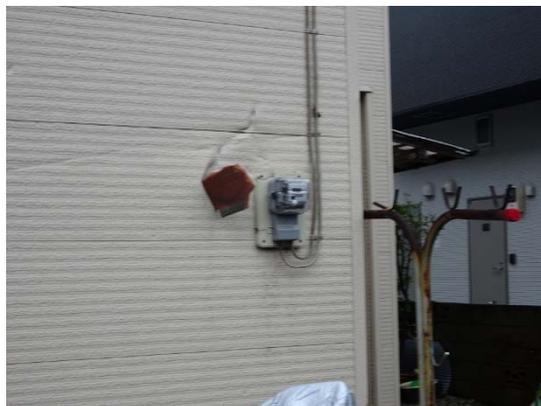
写真3 瓦が突き刺さった住家の壁面
