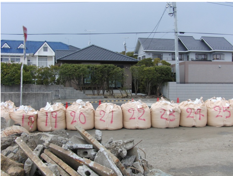
写真 19 倒壊した防潮堤広報の家屋
