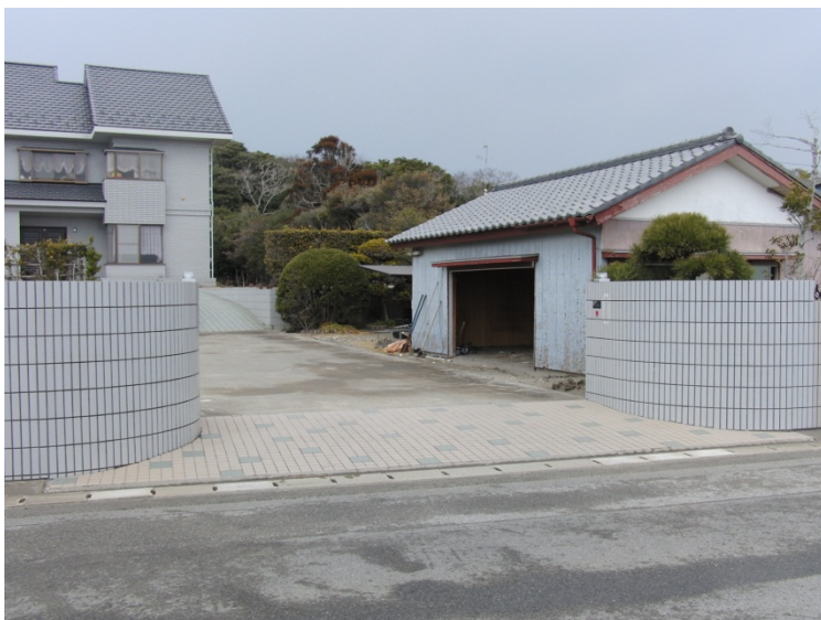
写真 22 被災した防潮堤後方の家屋
