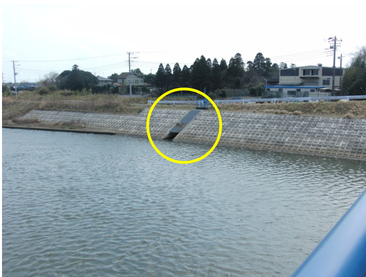
写真 25 河口から約 2.5km の鶴巻堰下流
