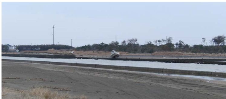
写真 9 尾形海岸河口部右岸の状況(左岸から撮影)
