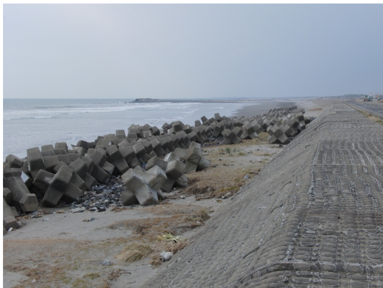
写真2 消波ブロックの状況
