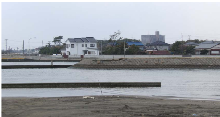
写真 10 尾形海岸河口部右岸護岸 (左岸から撮影)
