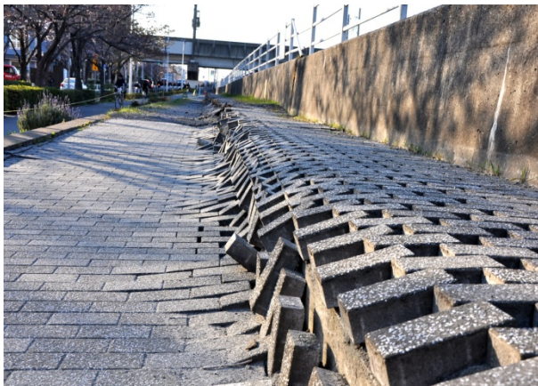
写真-20 境川沿いの遊歩道 （高洲1丁目）
