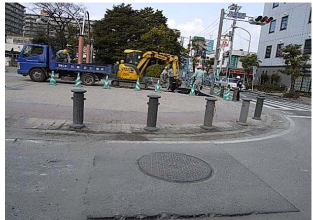
写真-14 集合住宅敷地内での復旧作業（入船6丁目）
