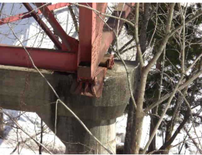
5) 栄大橋：遊間継ぎ手が空いたり、圧縮変形したりしている。さらに、橋台部の支承（右岸）が破壊しているが、が桁本体には大きな破壊は見られない。
