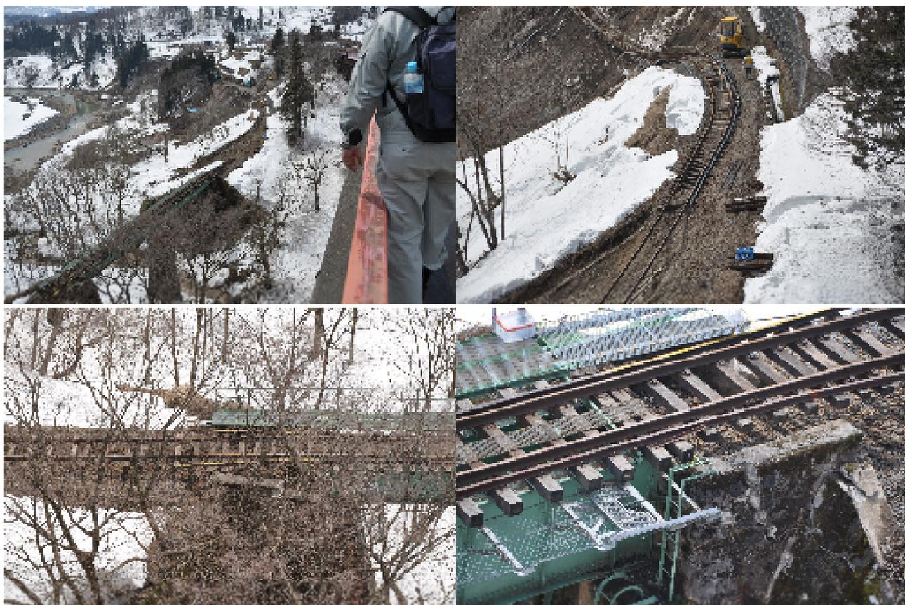
10) スノーシェットの破壊：一連のシェット（建設年次や形式が異なる）に崩落土砂（雪混じり）が衝突し、破壊。破壊性状から推定するに、荷重が少し谷川に押し出すように作用したと見られ、崩壊したシェットに接続するシェットにも柱部に大きなひび割れが観察された。
