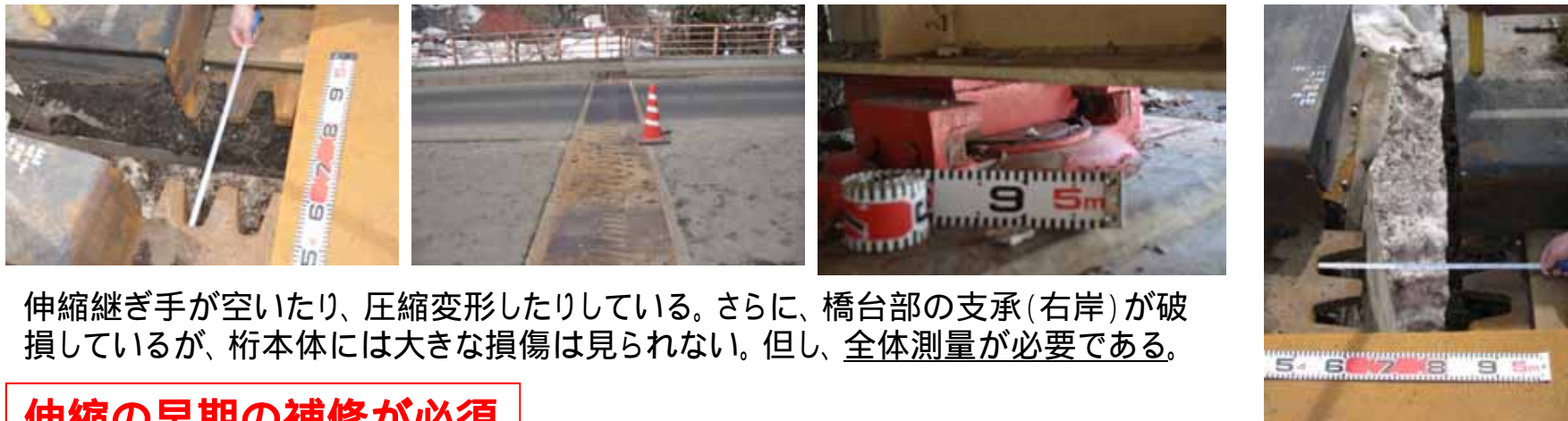
栄大橋津南側橋詰のジョイント部ずれ
