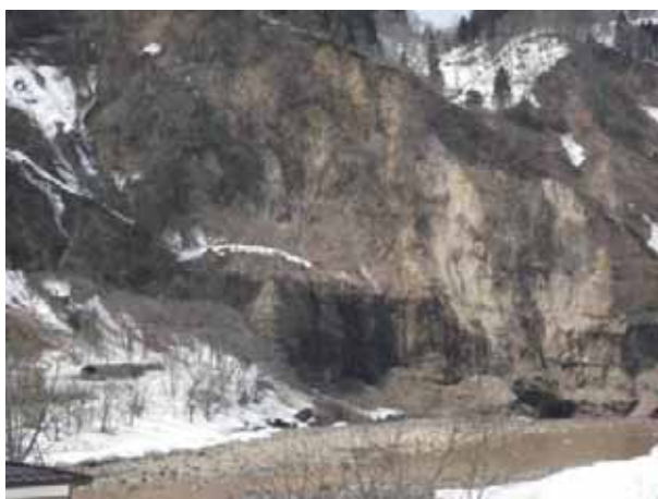
信濃川の中津川との合流点上流側左岸 河岸段丘斜面の崩落。左下のトンネルはJR飯 山線。
