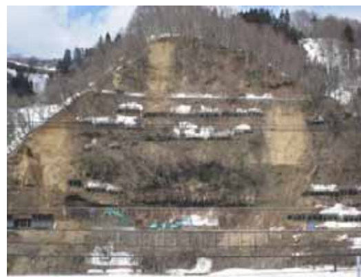
JR飯山線越後田中駅付近 河岸段丘斜面崩落により、雪崩予防柵や線路などが 破壊されている。鉄道については既に復旧工事が進め られている。
