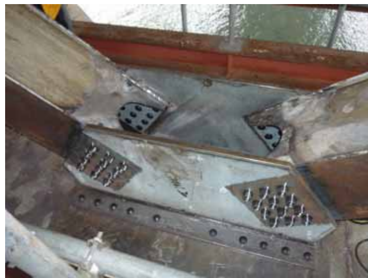
取付部材取替
