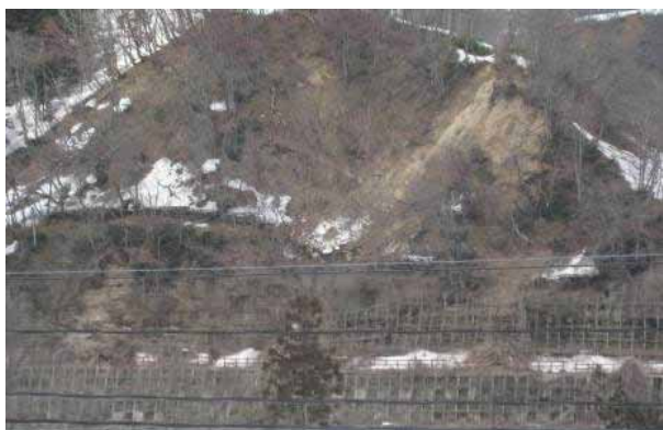
津南・信濃川左岸 河岸段丘斜面崩落により、雪崩予防柵や法 枠工などが破壊されている。
