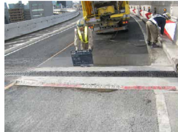
伸縮装置取替
