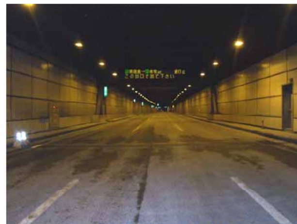
トンネル継目の漏水補修
