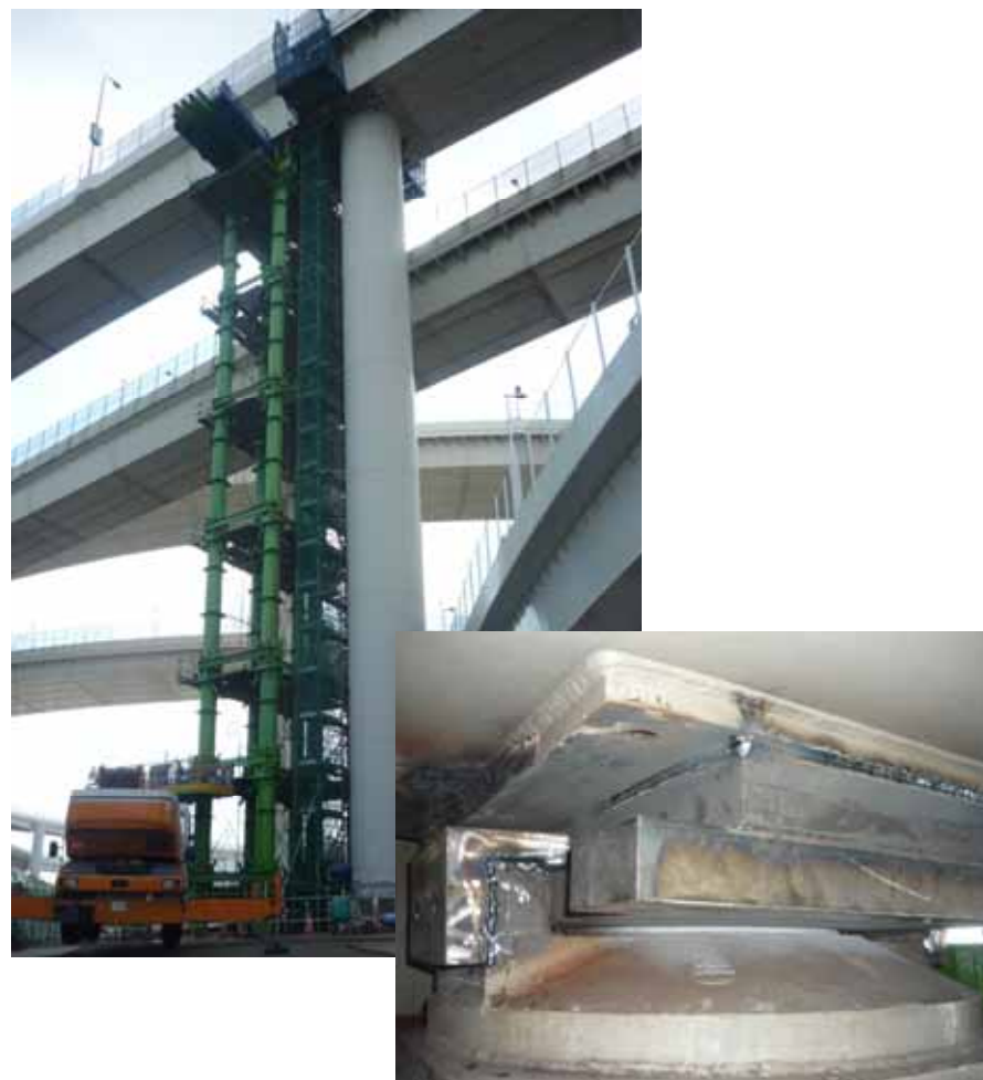
桁橋をベントで支持し、支承を補修
