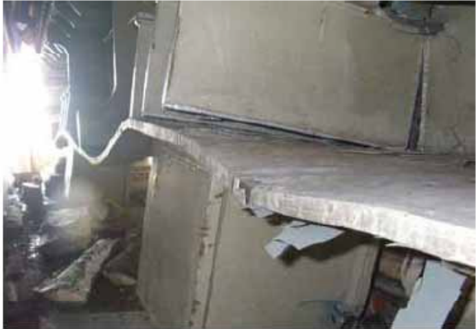
桁の変形
