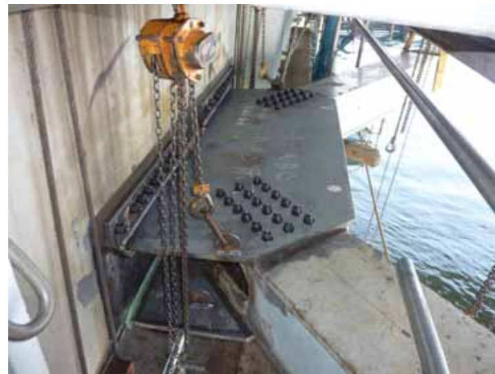
取付部材取替
