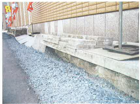
同左堤体亀裂発生 (直轄区間)
