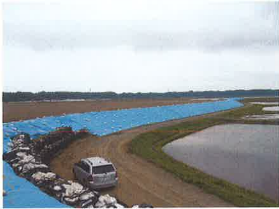
天端の沈下と亀裂
