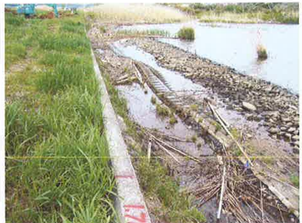
亀裂箇所の掘削と仮盛り土
