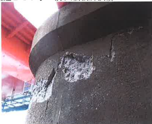
国道245号・湊大橋橋脚損傷
