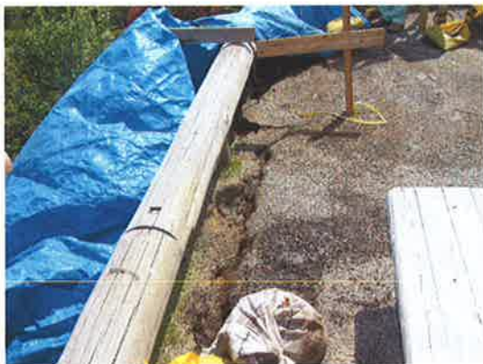
跨線エレベーター周辺の沈下
