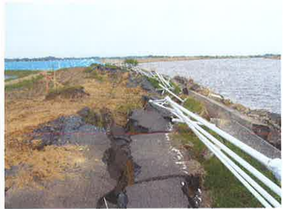
張りブロックの沈下
