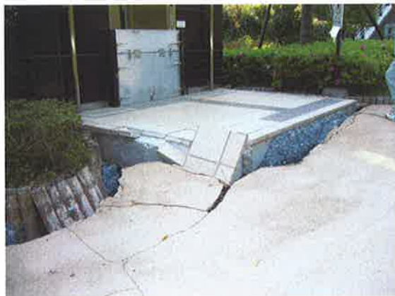
跨線エレベーター周辺の沈下
