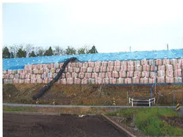
常磐道・那珂 I C 付近本線崩壊箇所 (那珂市)
