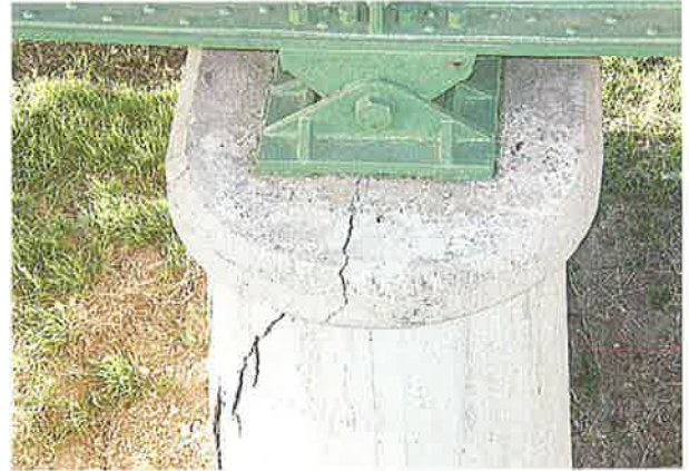
日立笠間線・機初橋（常陸太田市）
