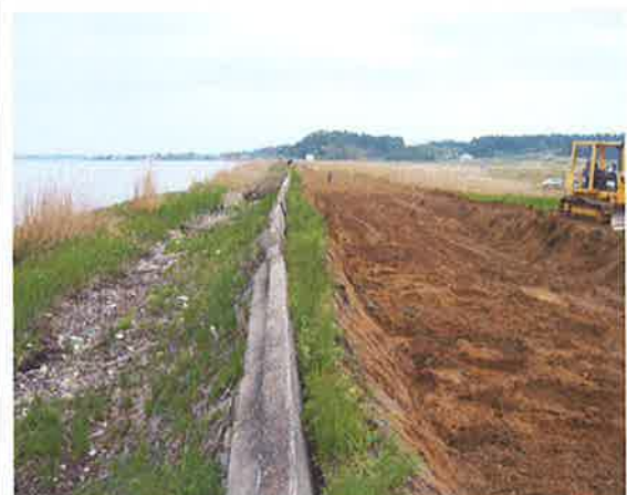
亀裂箇所の掘削と仮盛り土
