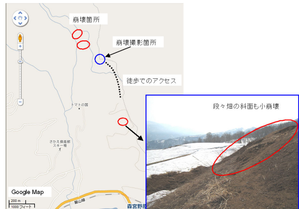
図2.6-2 崩壊箇所へのアクセス
