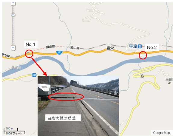
図2. 3-1 栄村豊栄の国道117号の被害箇所
