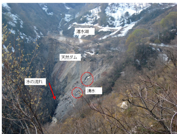
写真2. 6-4 北信の斜面崩壊（湛水湖下部）
