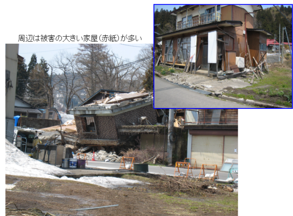
写真2.4-4 民家の被害 (図2.4-1のNo. 3の箇所)
