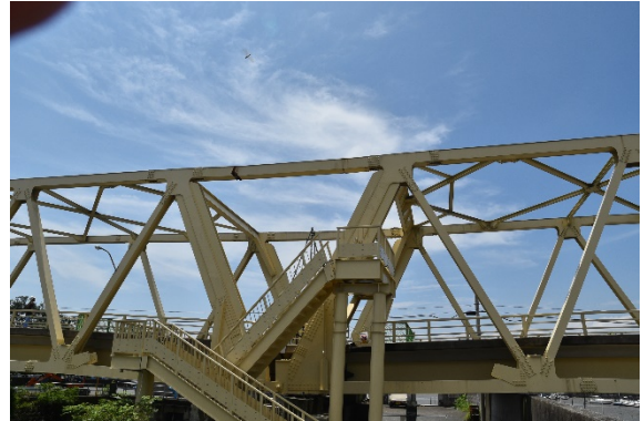
図5. 2. 34 横江大橋中間橋脚部歩道階段の被害
