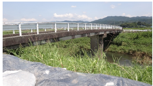
図5.2.31 第二宮園橋全景
