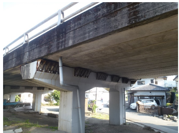
図5.2.20 寺迫橋の橋桁状況
