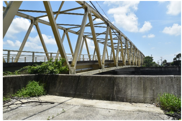
図5. 2. 33 横江大橋全景
