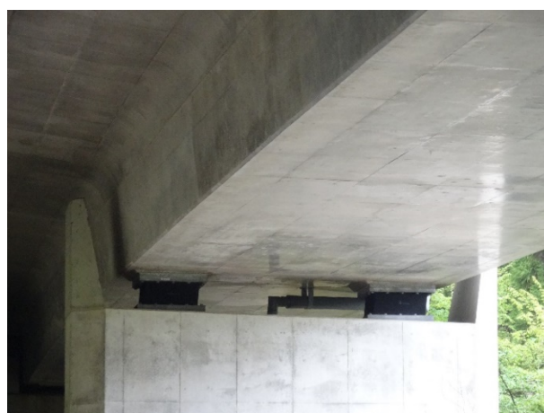
図 5.1.14 本震後の福万川橋 (上り線のゴム支承は健全)
