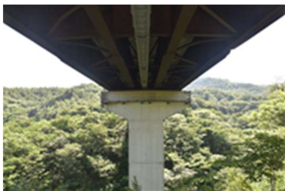
図5.2.9 熊本側から望む橋脚および主桁
