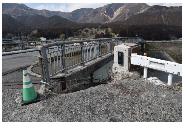
図5.2.35 大正橋の橋台部付近
