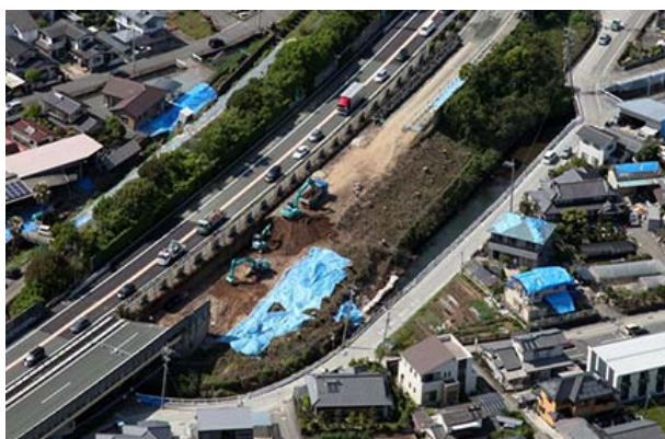
図 5.1.1 盛土法面崩壊 1)
