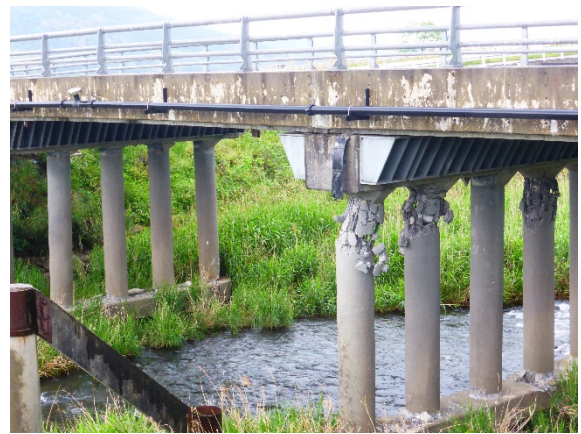
図5.2.30 第一畑中橋全景
