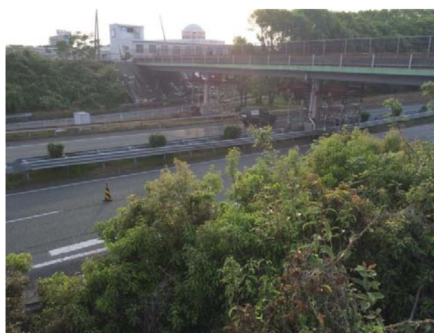
写真 6.6.1 (b) 九州自動車道熊本 IC 付近の跨道橋の倒壊
