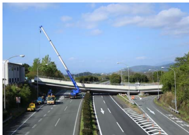
写真 6.6.1 (a) 九州自動車道緑川 PA 付近の跨道橋の倒壊
