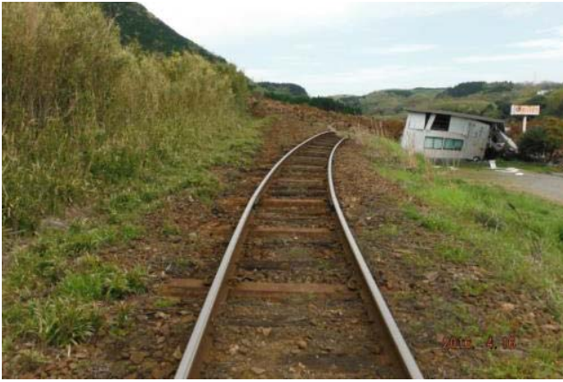
写真 6. 6. 3 崩壊土砂に押し流された JR 豊肥線の線路
