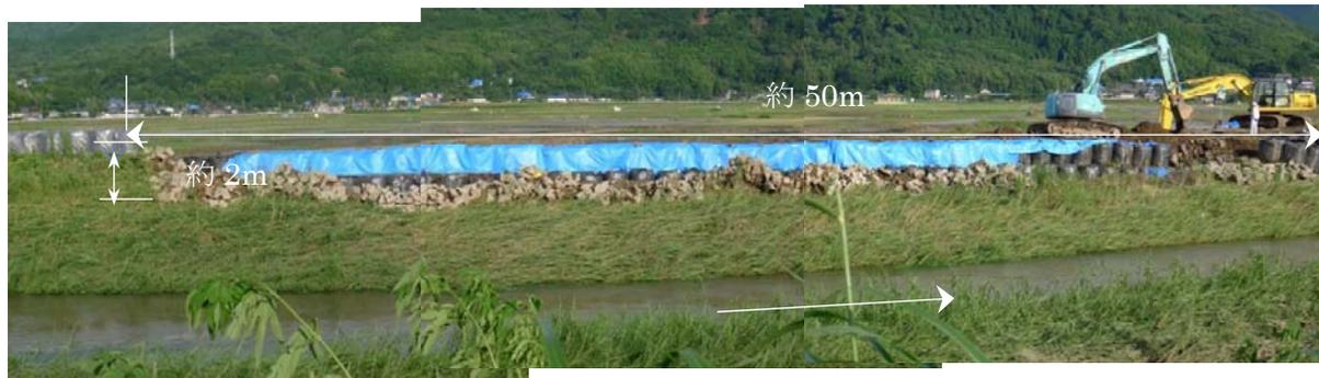
図 7.1.19 木山川左岸破堤の復旧 (6月 23 日 17 時)
