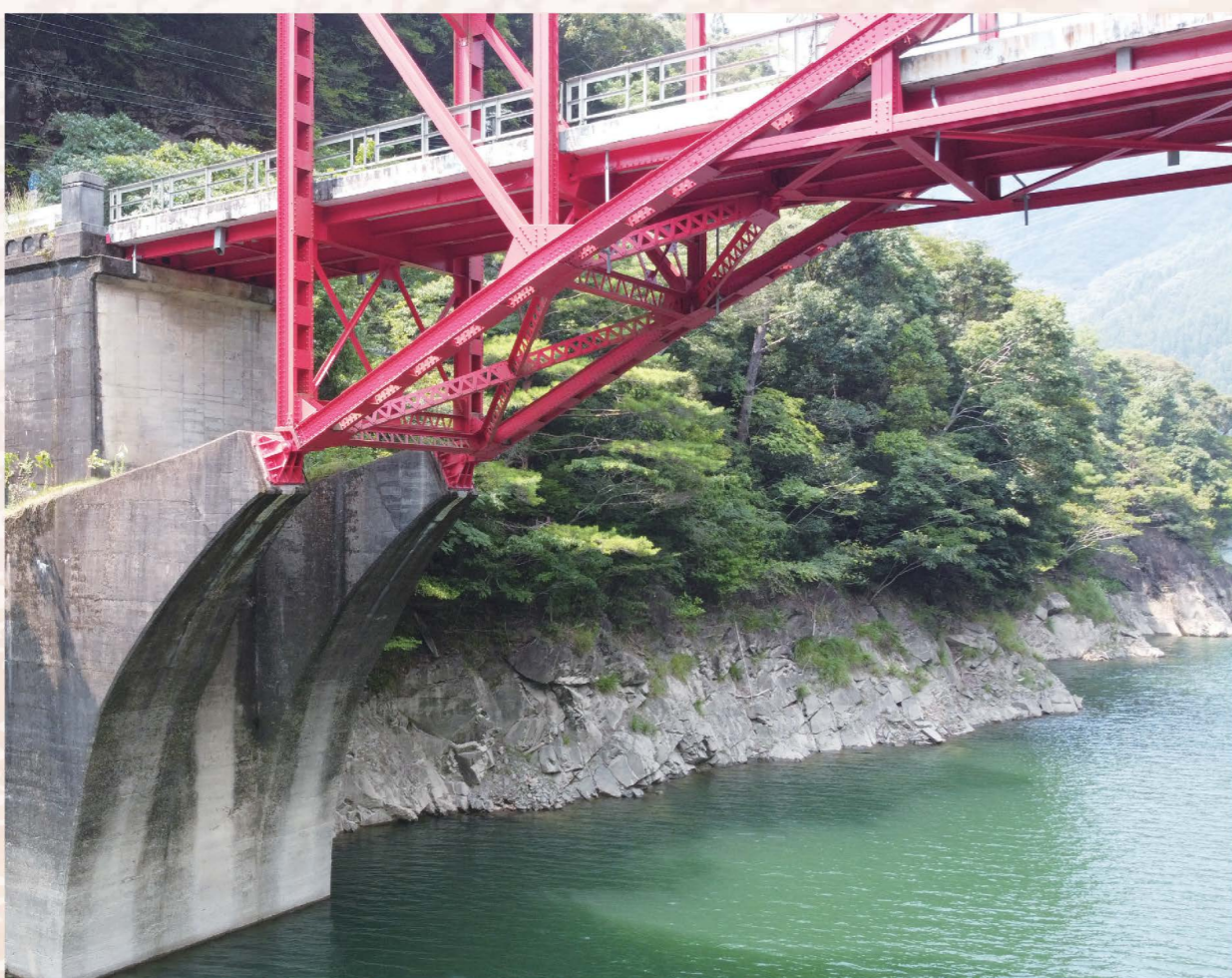
▲尾鈴橋右岸側
